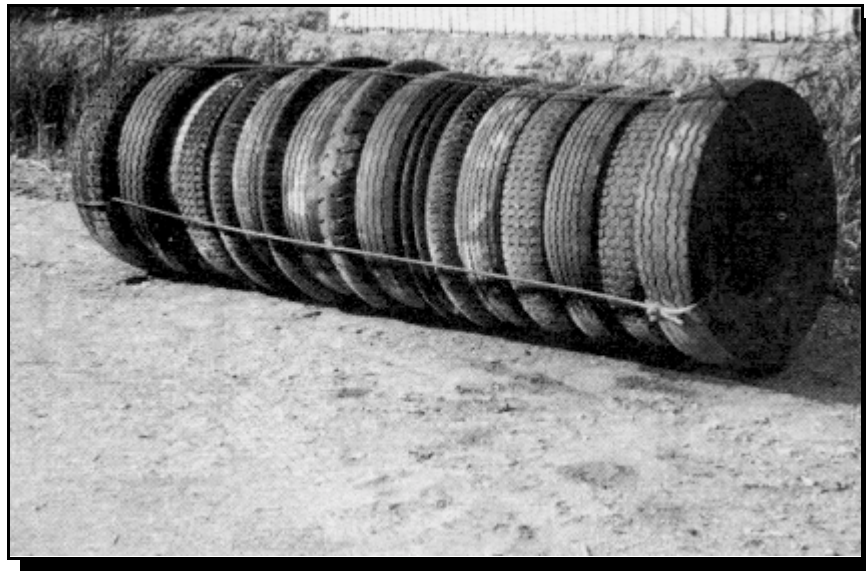
Figura 2.4 - Emprego de pneus em obras de drenagem
